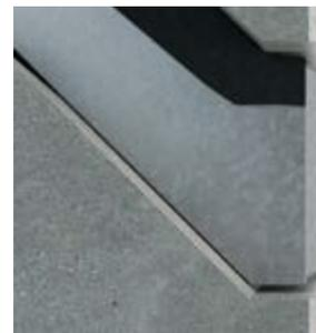
Wir empfehlen, dass das Mauerwerk die Entnahmetür überragt. Dadurch wird verhindert, dass Regenwasser, welches an der Mauer nach unten fließt, zwischen Entnahmetür und Hinterkasten eindringen kann.
