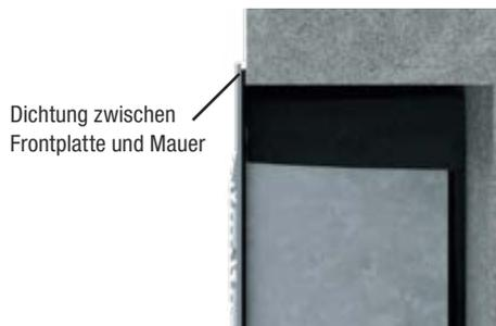
Die Abdichtung zwischen Frontplatte und Mauerwerk muss bauseits erfolgen. Manchmal müssen starke Unebenheiten mit zusätzlichem Verputz- oder Dichtungsmaterial ausgeglichen werden.
